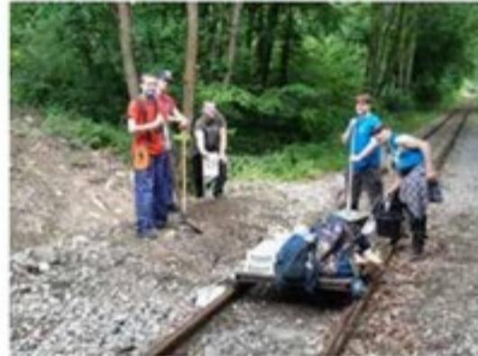
Staré drevené hektometrovníky sme vymenili a doplnili za nové, vyrobené pre našu úzkorozchodnú 4-kilometrovú trať na mieru. Slúžia pre lepšiu orientáciu na trati a sú vyrobené z odolnejšieho materiálu. Ak by vám niečo počas jazdy vypadlo, stačí si zapamätať číslo na hektometrovníku a hľadanie bude rýchlejšie.
